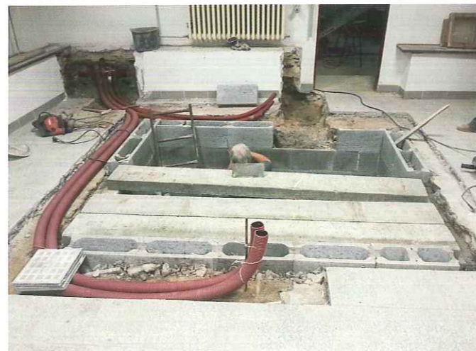
Obr. 2: Stavba podzemní částečně zastropené zásobní jímky, chráničky pro vedení kabelových tras
