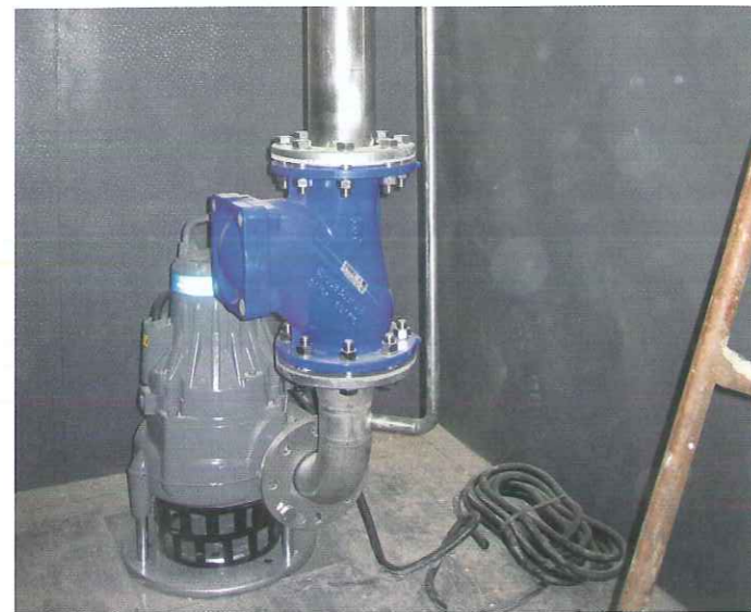
Obr. 5: Čerpadlo instalované na dno jímky se zavzdušňovacím potrubím oběžného kola, zpětnou klapkou s koulí a ukotvením výtlačného potrubí ke stropu jímky
