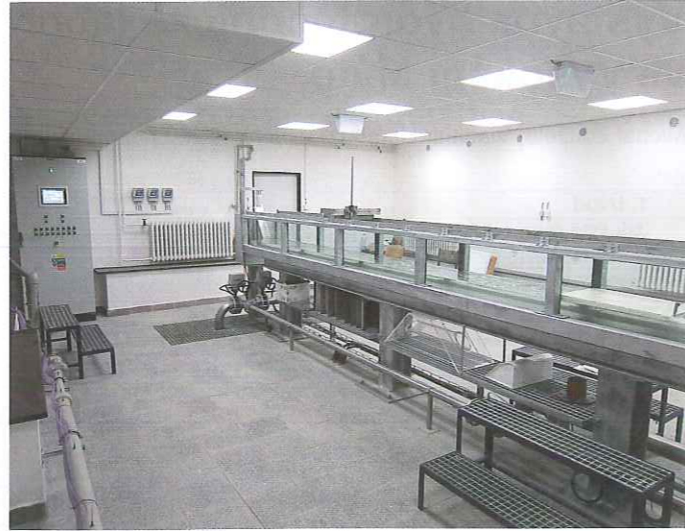
Obr. 7: Celkový pohled na hydraulický okruh laboratoře, vlevo tlaková měrná trať a rozváděč s vizualizačním displejem, vpravo měrný žlab s rozvodnými potrubími
